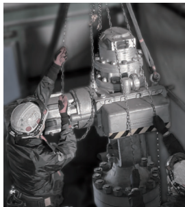
発電所での点検作業風景
