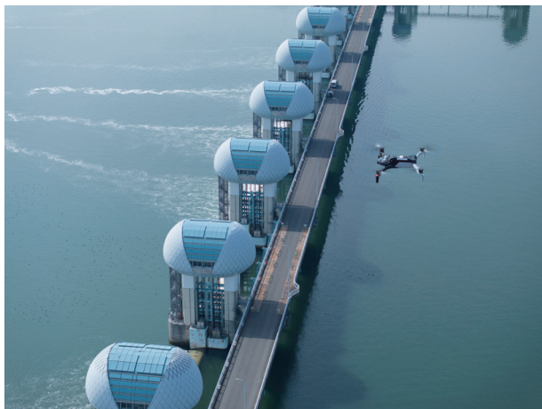
ドローンによる遠隔点検
