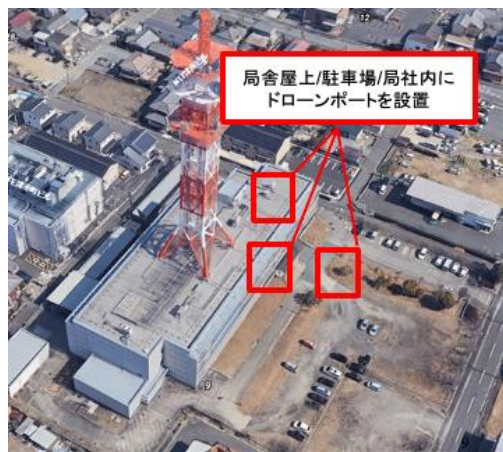
＜津市の通信局舎屋上のドローンポート＞
