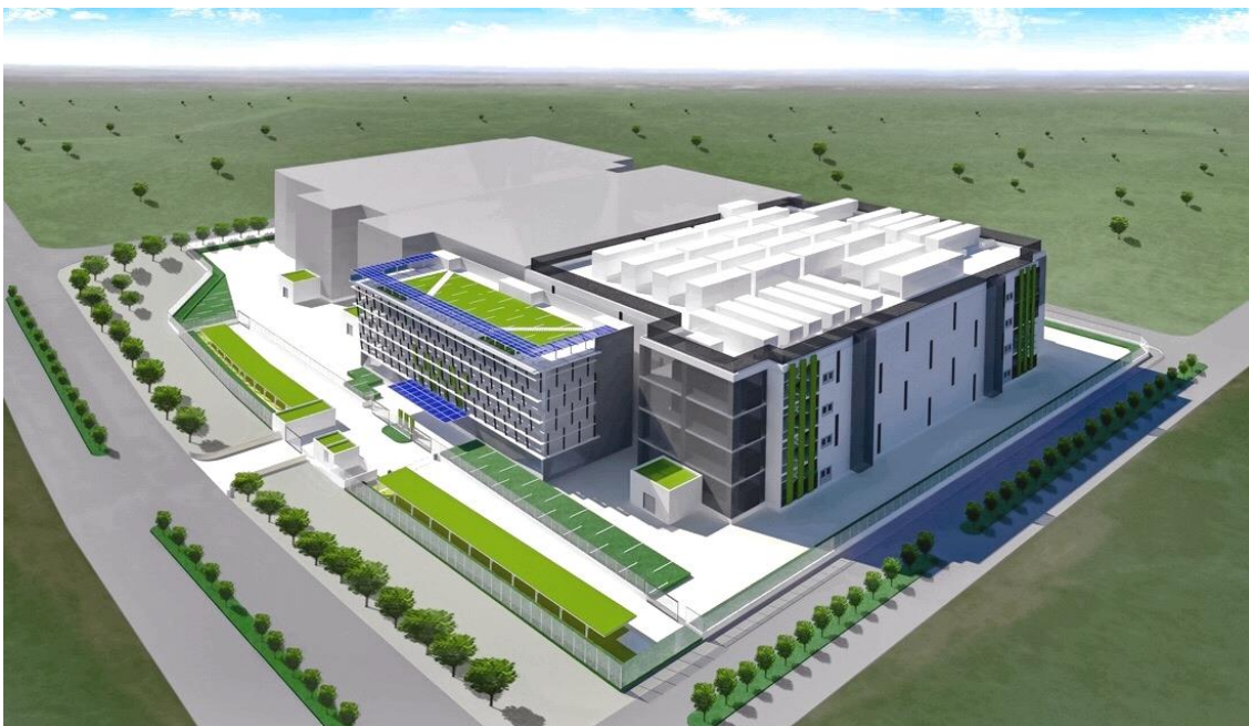
「インドネシア ジャカルタ 3 データセンター」の外観イメージ
