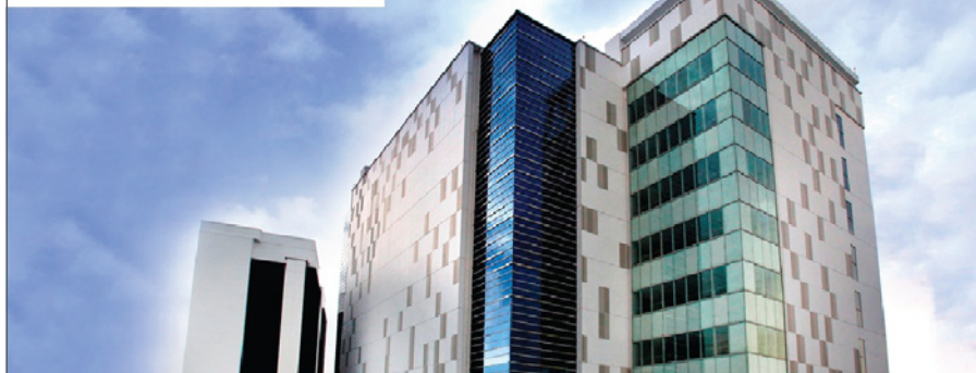
Indonesia Jakarta 2 Data Center
