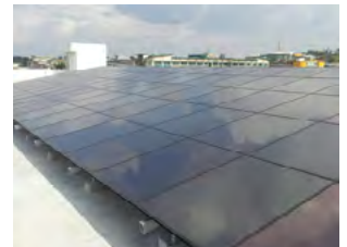
マレーシアのデータセンタービルの屋上に設置した太陽光パネル
