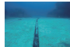
◆ サンゴ礁帯を避けて砂地に敷設
