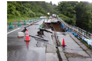
[ 山形～福島間の被災状況 ]
